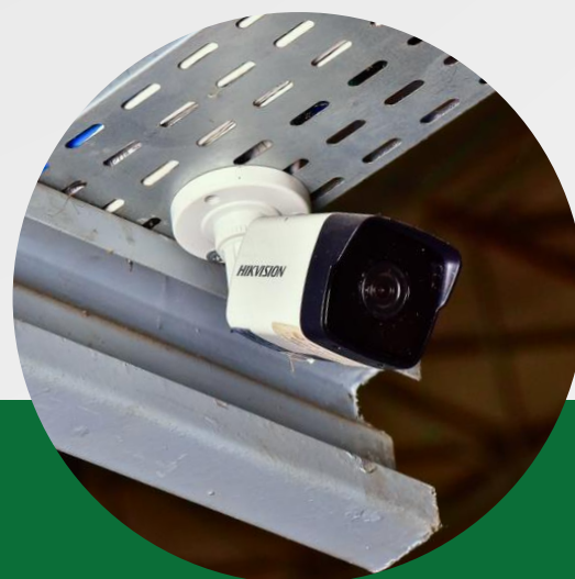
Instalação de Alarmes e Câmeras
