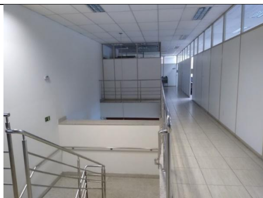
FOTO 21. VÃO A SER FECHADO FORRO E GUARDA CORPO
