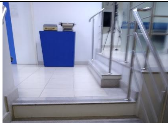
FOTO 20. GUARDA CORPO E ESCADAS
