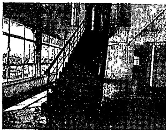
FOTO 25: 20º PAVTO | Escada de acesso ao 21º pavimento
